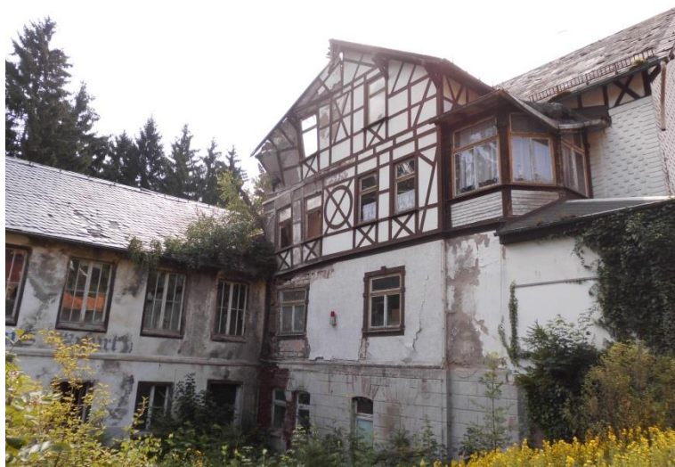
Starker baulicher Verfall an dem seit Jahren leerstehenden „Haus Erfurt“ in Finsterbergen
