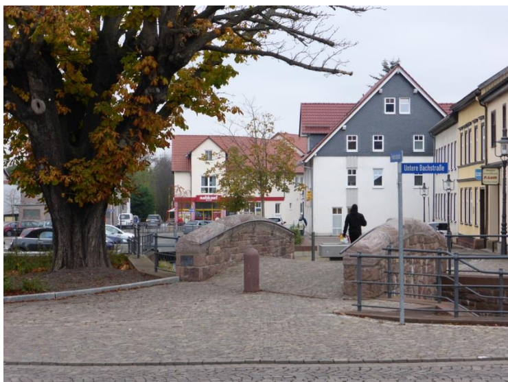
Brücke über das Schilfwasser im Bereich der Unteren Bachstraße
