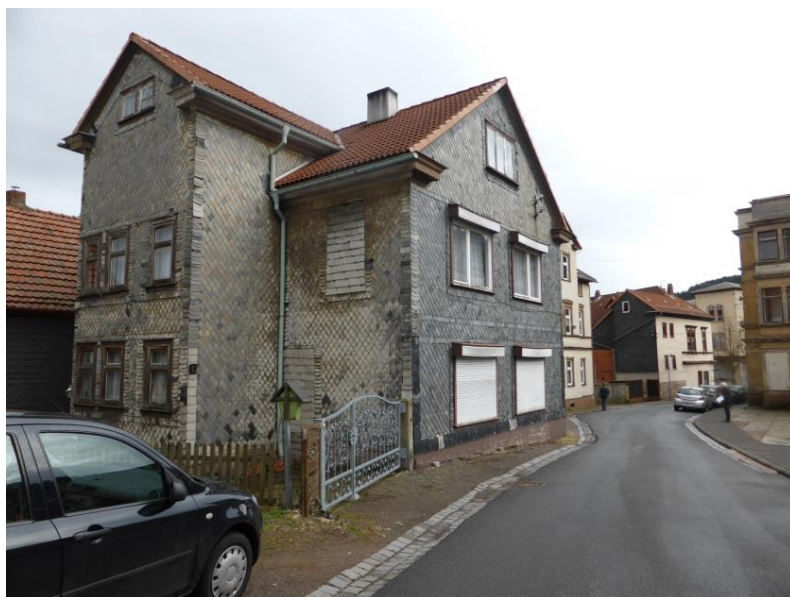
Das Gebäude Burgstraße 6 steht sehr dicht im Verkehrsraum und schränkt diesen stark ein. Aufgrund der geringen Brüstungshöhen im Erdgeschoss besteht nur ein geringer Abstand zum fahrenden Verkehr.
