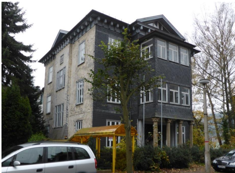
Das leerstehende Gebäude Alexandrinenstraße 6 (ehemaliges Hotel Klosterberg) ist aufgrund der Größe schwer umnutzbar.
