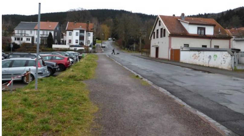
Hoher Sanierungsbedarf im Bereich der Schillerstraße und des Parkplatzes.
