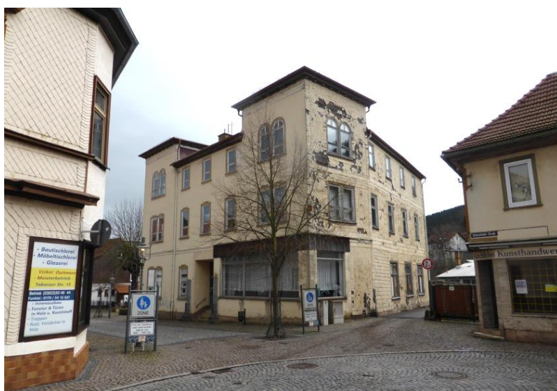
Das leerstehende ehemalige Hotel am Rande der Fußgängerzone stellt einen gravierenden Missstand im Ortsbild dar.
