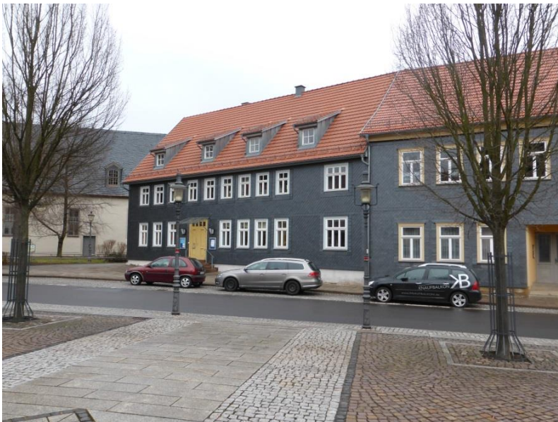
Die Kirchgasse führt direkt zum Kirchplatz. Hier fällt der Blick zunächst auf zwei Gebäude mit ortstypischer Schieferfassade.
