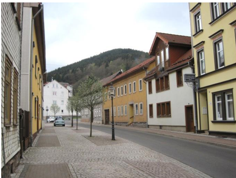
Etwas entfernt vom Stadtzentrum sind in den Erdgeschosszonen der Wohnhäuser keine Geschäfte mehr vorhanden. Die geschlossene Bebauung ist vielfach vorherrschend. Sanierte Straßen und Nebenflächen prägen das Ortsbild in weiten Teilen.
