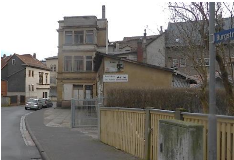
Rückwärtige Ansicht der Gebäude Schalkalder Straße 1 und 3
