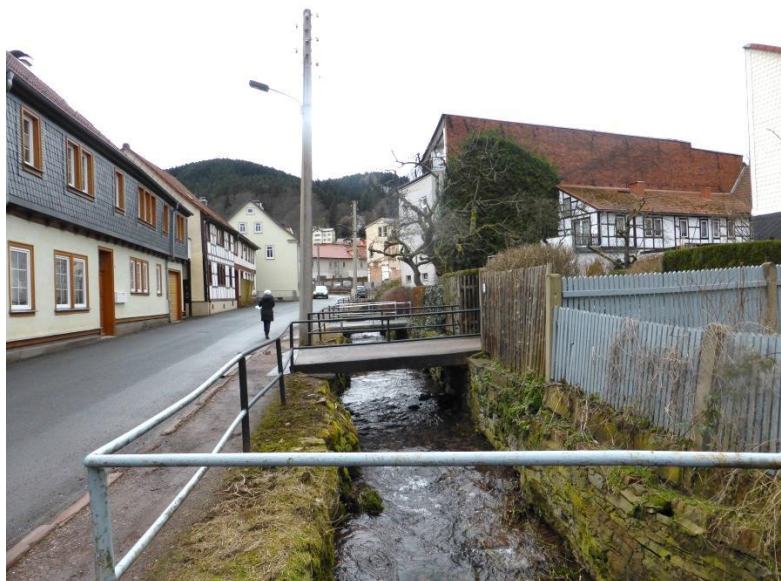
Die Bachstraße verläuft parallel zur Hauptstraße. Zahlreiche kleine Brücken erschließen die rückwärtigen Grundstücke. Hier wären eine Sanierung des Bachbereiches und eine wirkungsvolle Einbeziehung in das Stadtbild wünschenswert.
